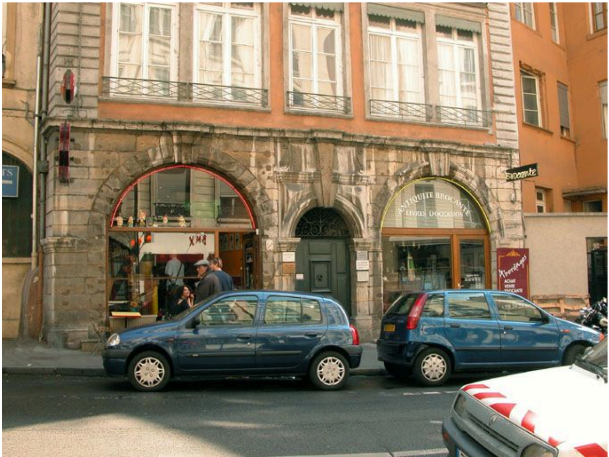
Façade sur rue, rez-de-chaussée
