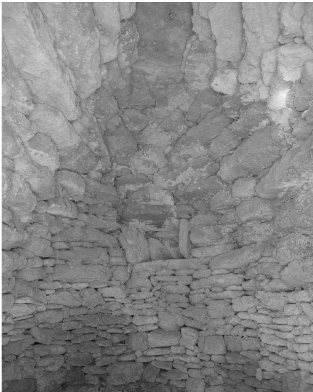
Taulignan, Esclouseau. Couvrement intérieur de la borie : principe de la coupole en encorbellement.
