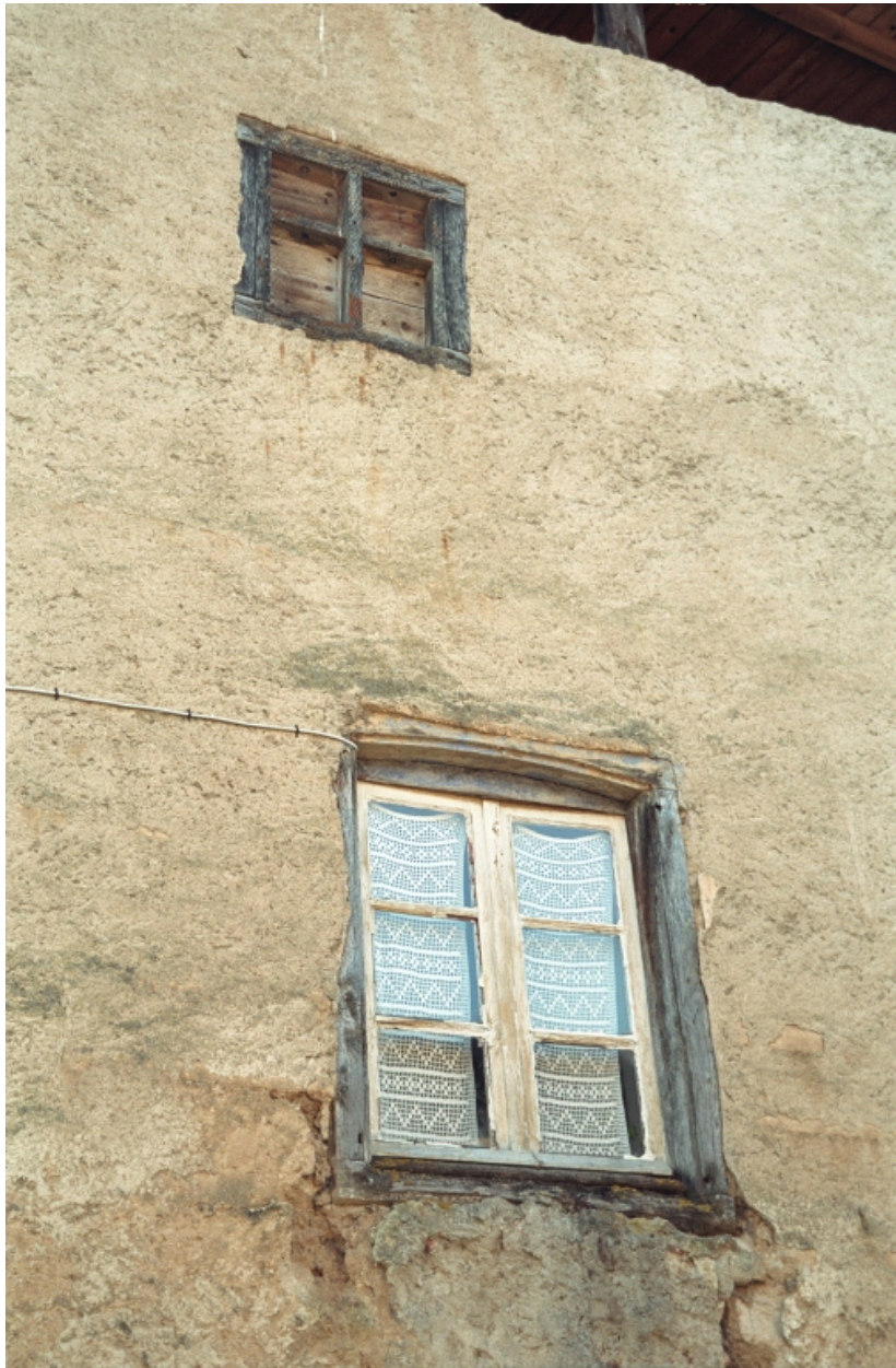
Débats-Rivière-d'Orpra, le Martel, 1987 A2 1060. Baies à encadrement de bois du 18e siècle.
