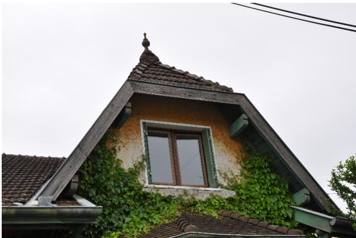
Détail de la lucarne pignon
