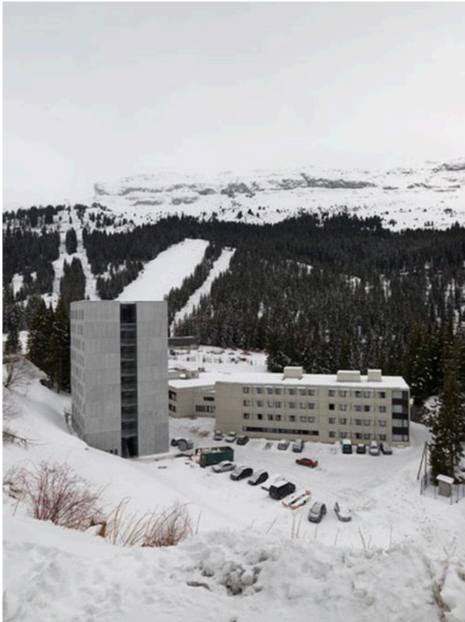
Vue d'ensemble dans le site depuis le nord
