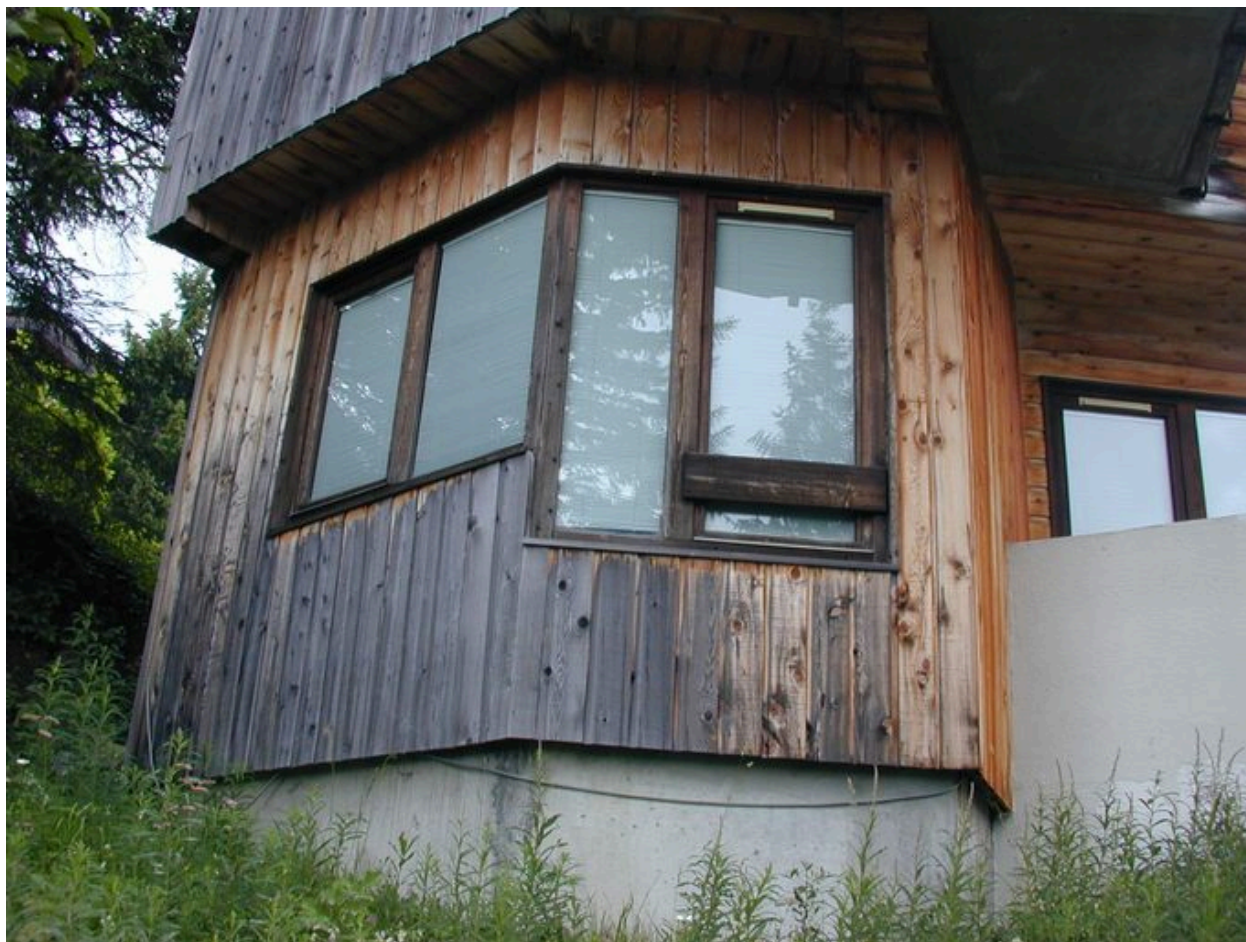
Elévation sud à l'aval, détail du soubassement
