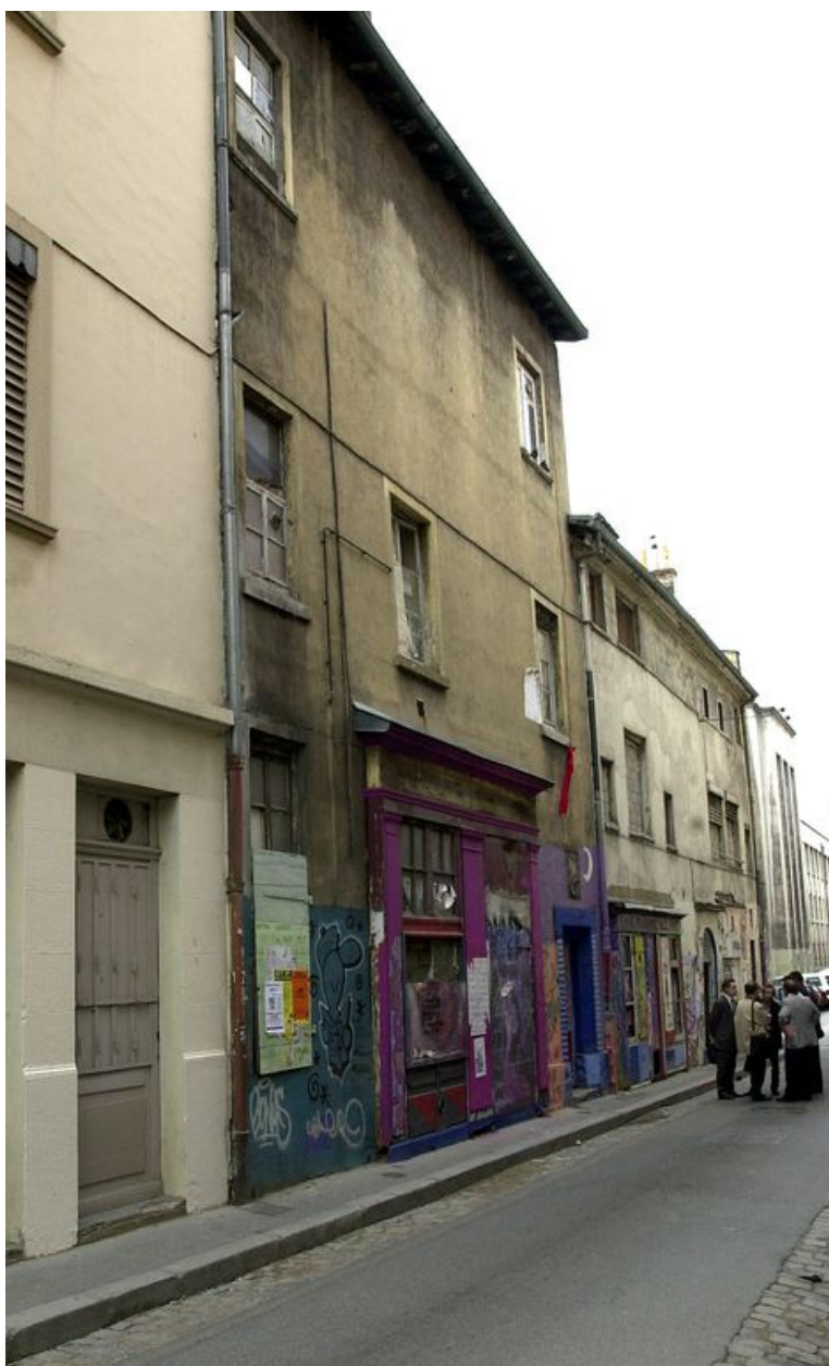
Corps du n° 14, façade sur rue
