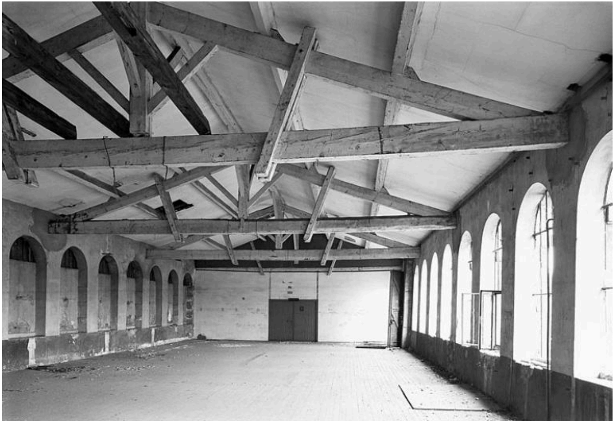
Vue intérieure de l'aile sud, charpente en bois
