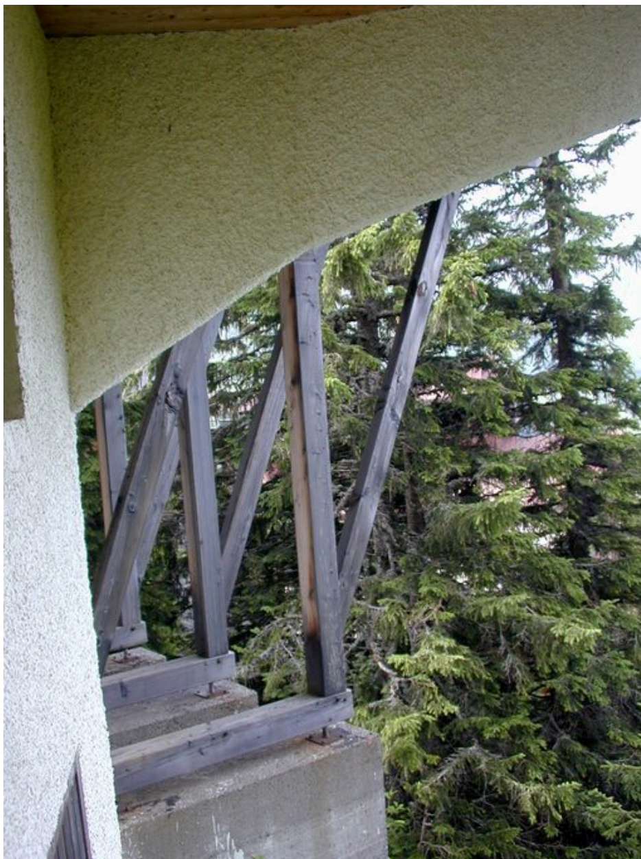
Détail des supports de l'encorbellement et du balcon
