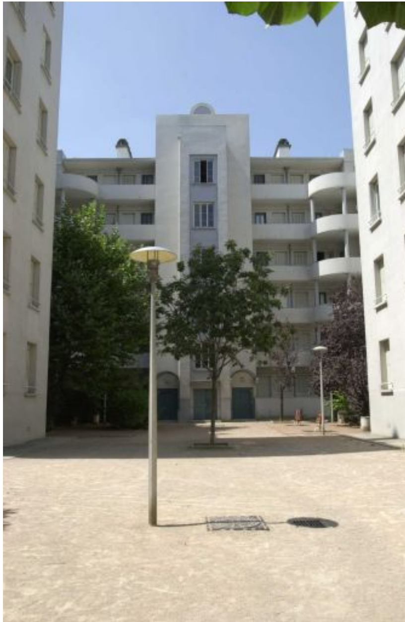
Elévation postérieure du 69 rue Delandine, la cage d'escalier hors-oeuvre
