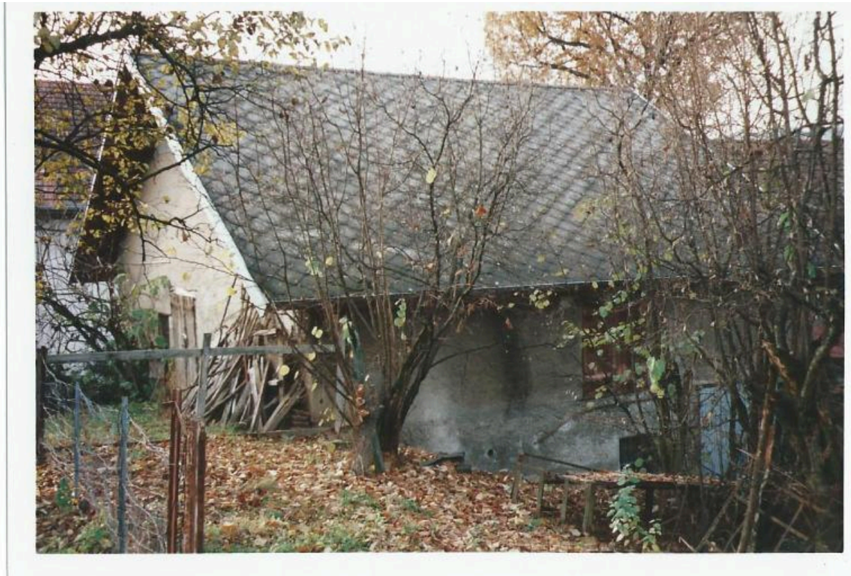
Pignon sud et façade sur jardin de la grange, avant transformation, 1998
