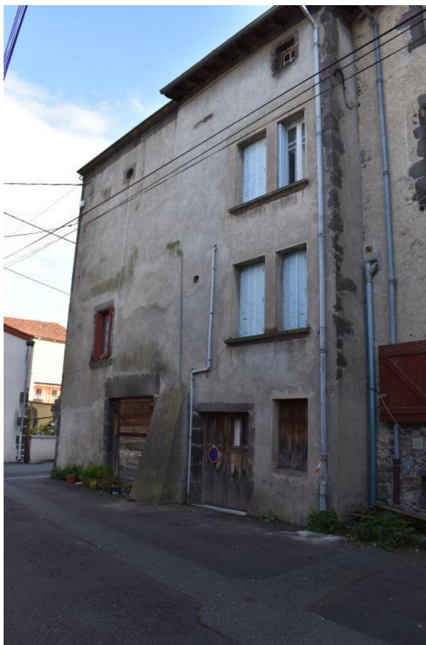
Vue générale : élévation arrière (nord)
