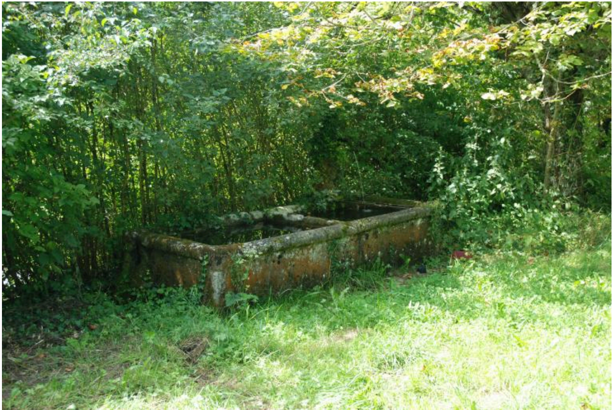
Vue d'ensemble du bassin en pierre.
