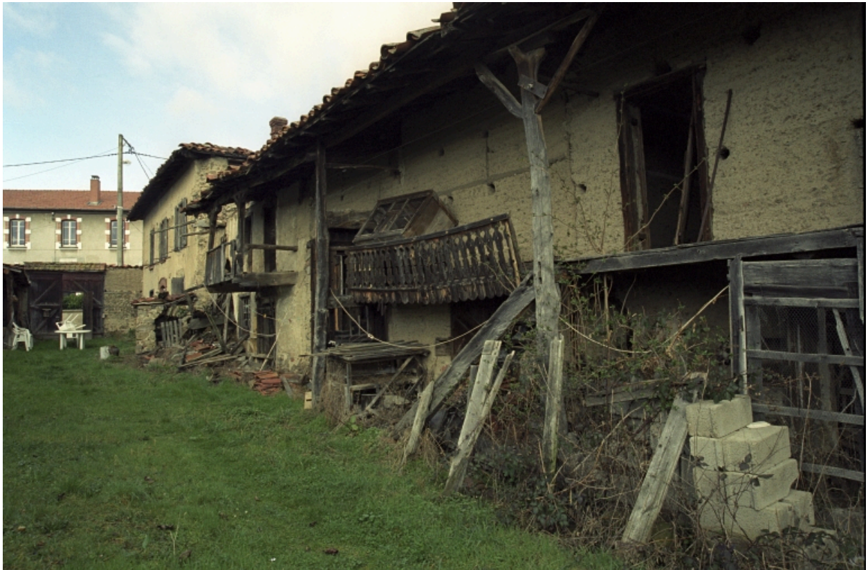
Vue d'ensemble depuis le fond de la cour.
