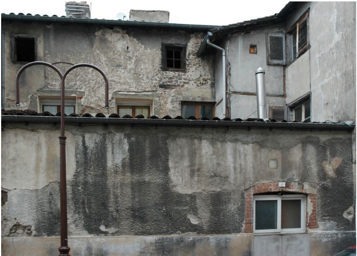
Vue partielle des élévations donnant sur la cour fermée.
