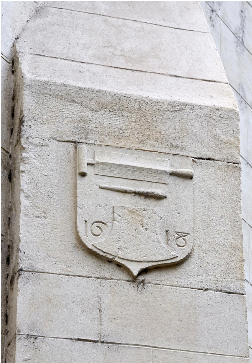
Elévation ouest, contrefort 3, écu portant la date de 1618
