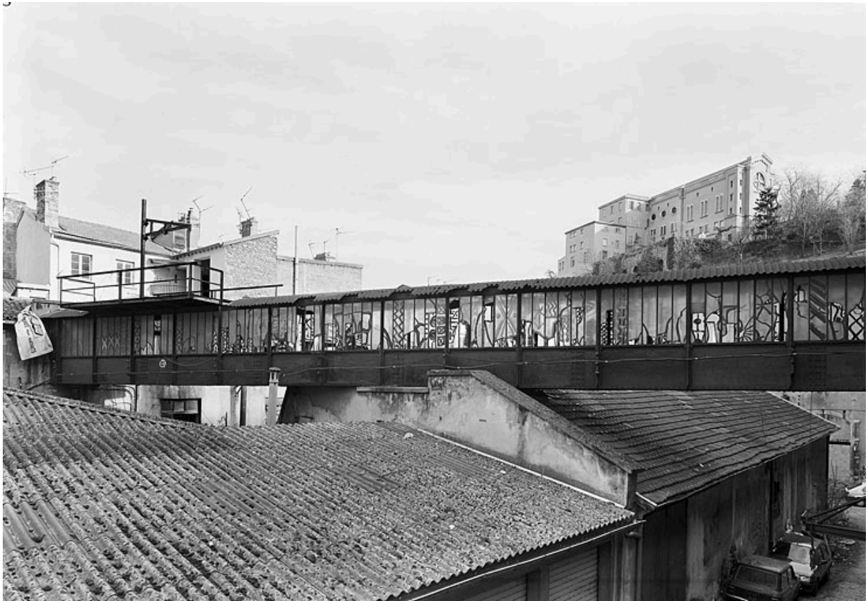
Passerelle métallique reliant deux ateliers
