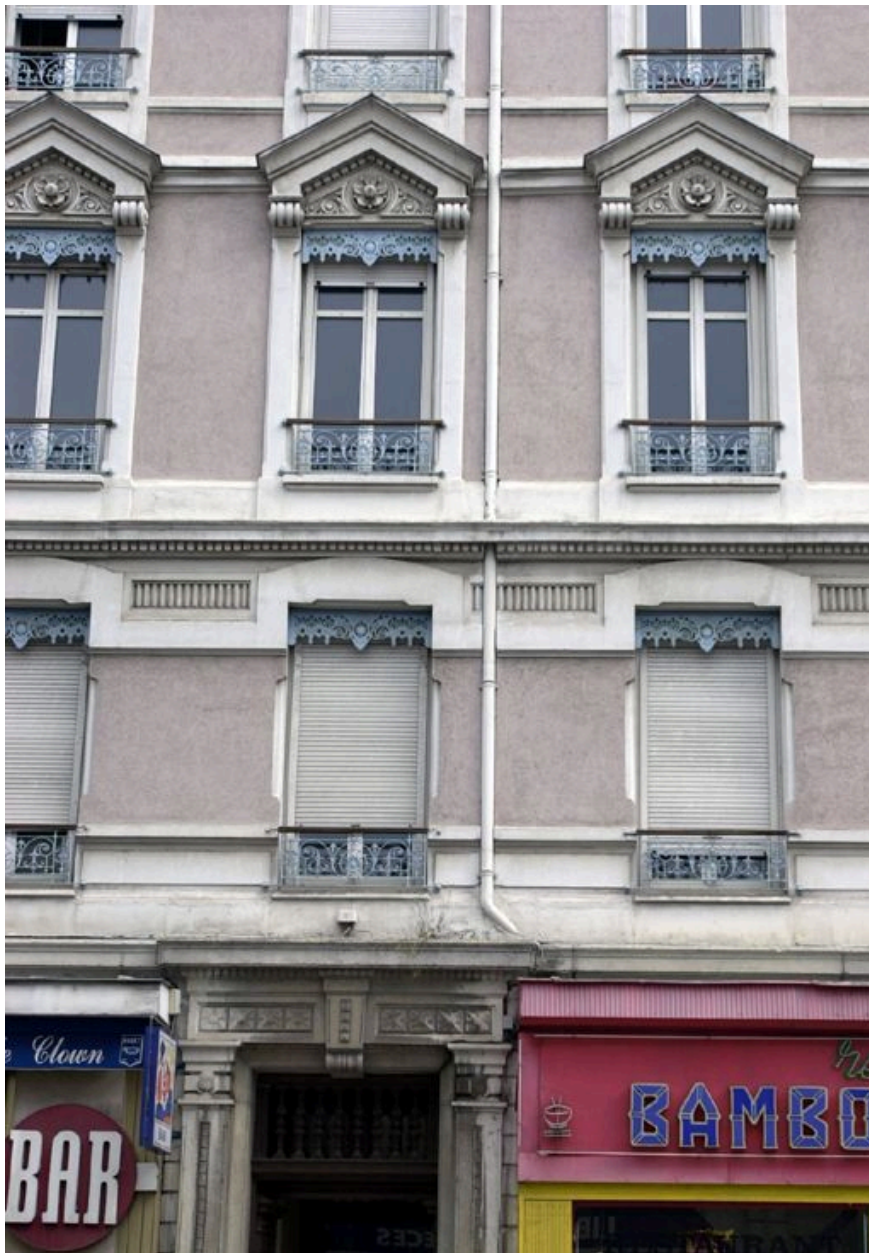
Elévation antérieure, détail de l'entresol et du 1er étage
