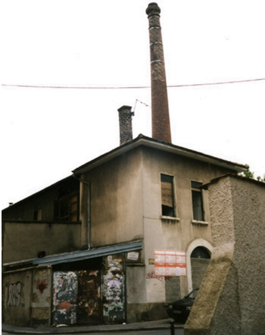
Vue angle rue Calas et rue de Cuire (+ ZE)
