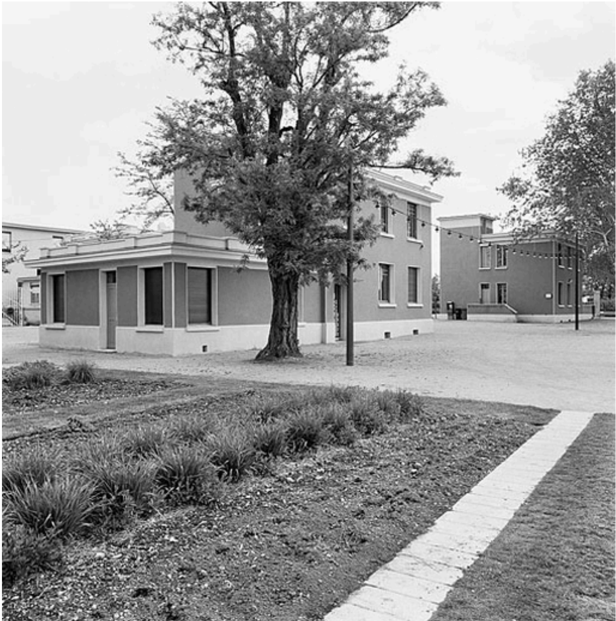
Pavillons administratifs de l'ancienne usine chimique
