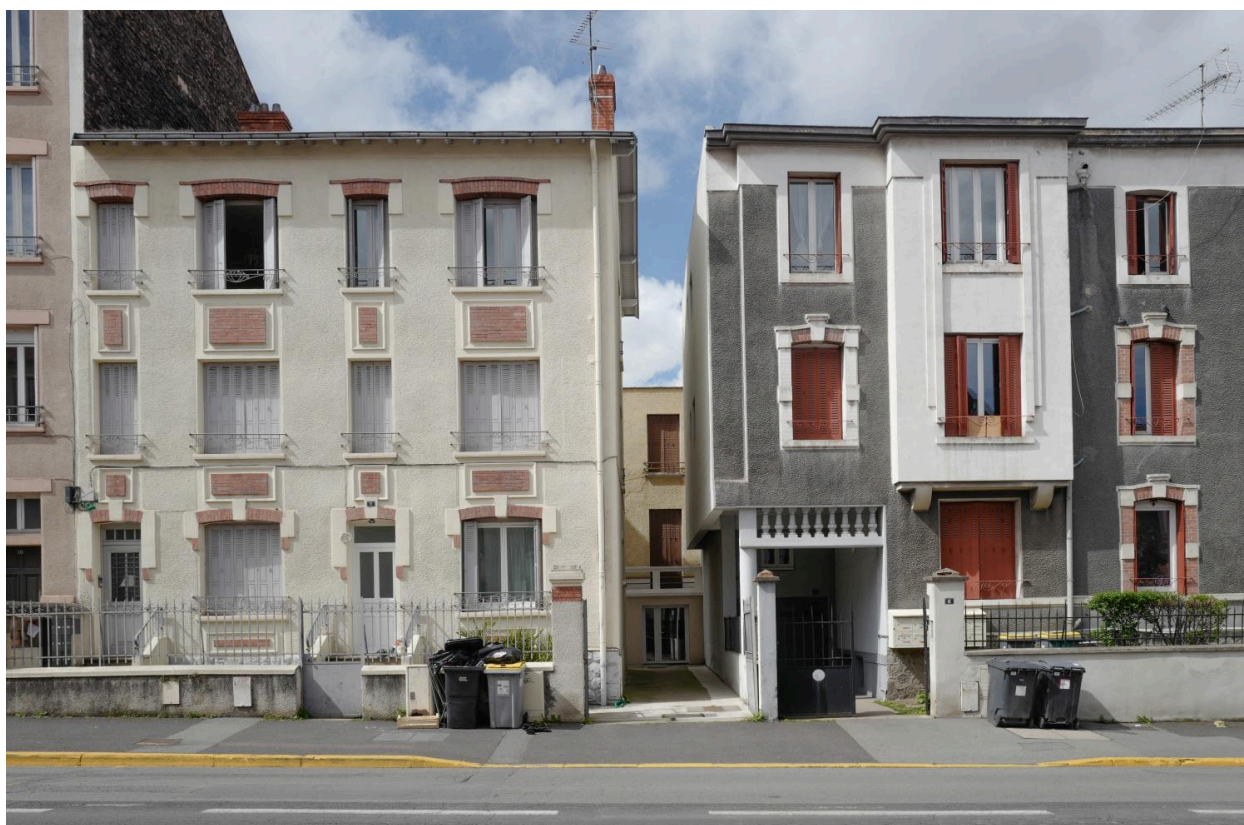
Allée de desserte de fond de parcelle entre les n°6 et 8 boulevard Fleury
