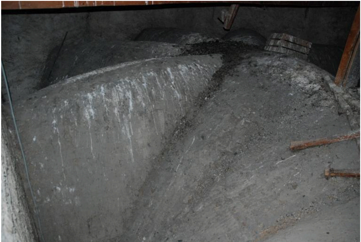
Vue des voûtes d'arêtes visibles sous les toits.
