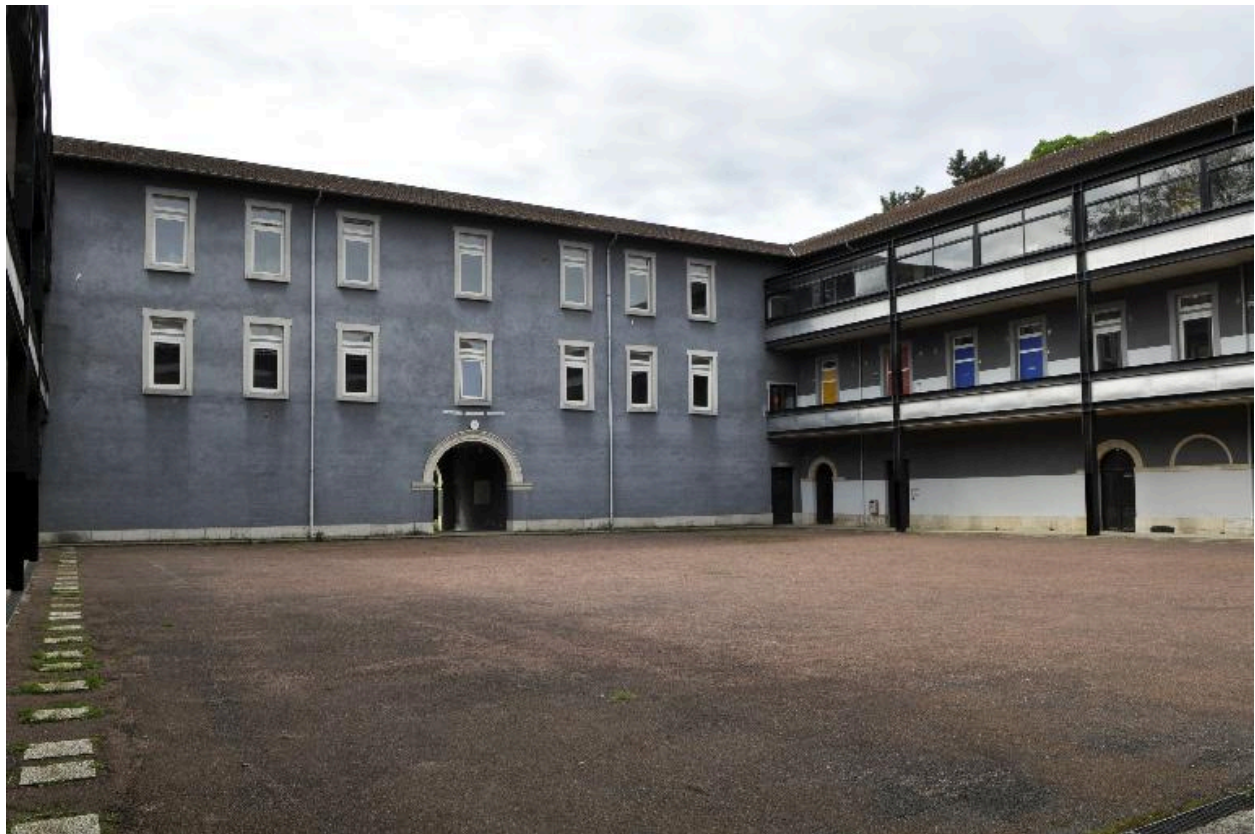
Cour des communs en 2016 : corps de bâtiment sud, depuis le nord-est
