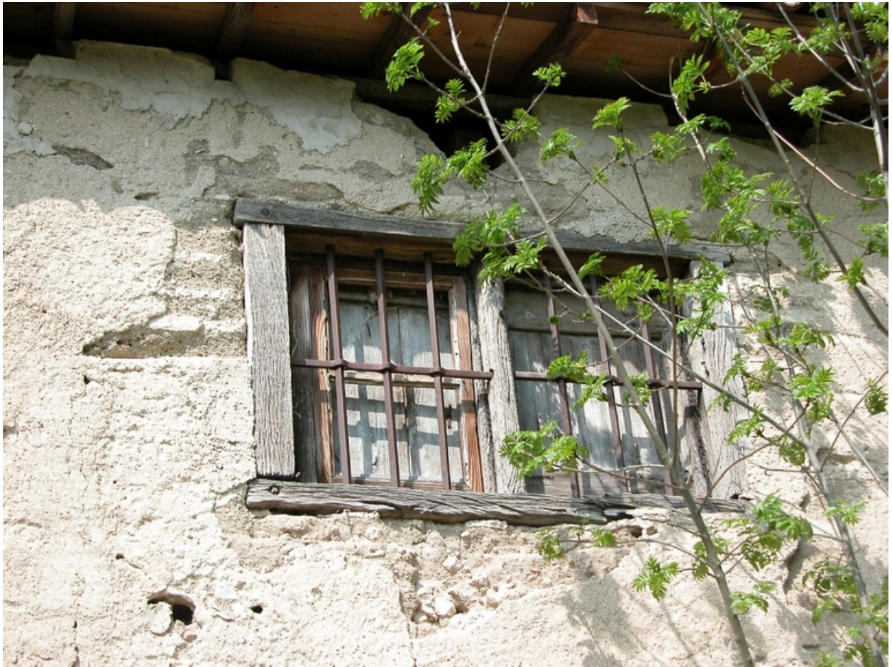
Détail d'une fenêtre de l'étage de l'habitation sud des communs, côté sud.
