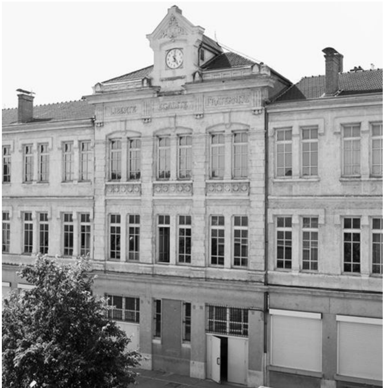
Vue partielle de l'élévation antérieure du bâtiment principal
