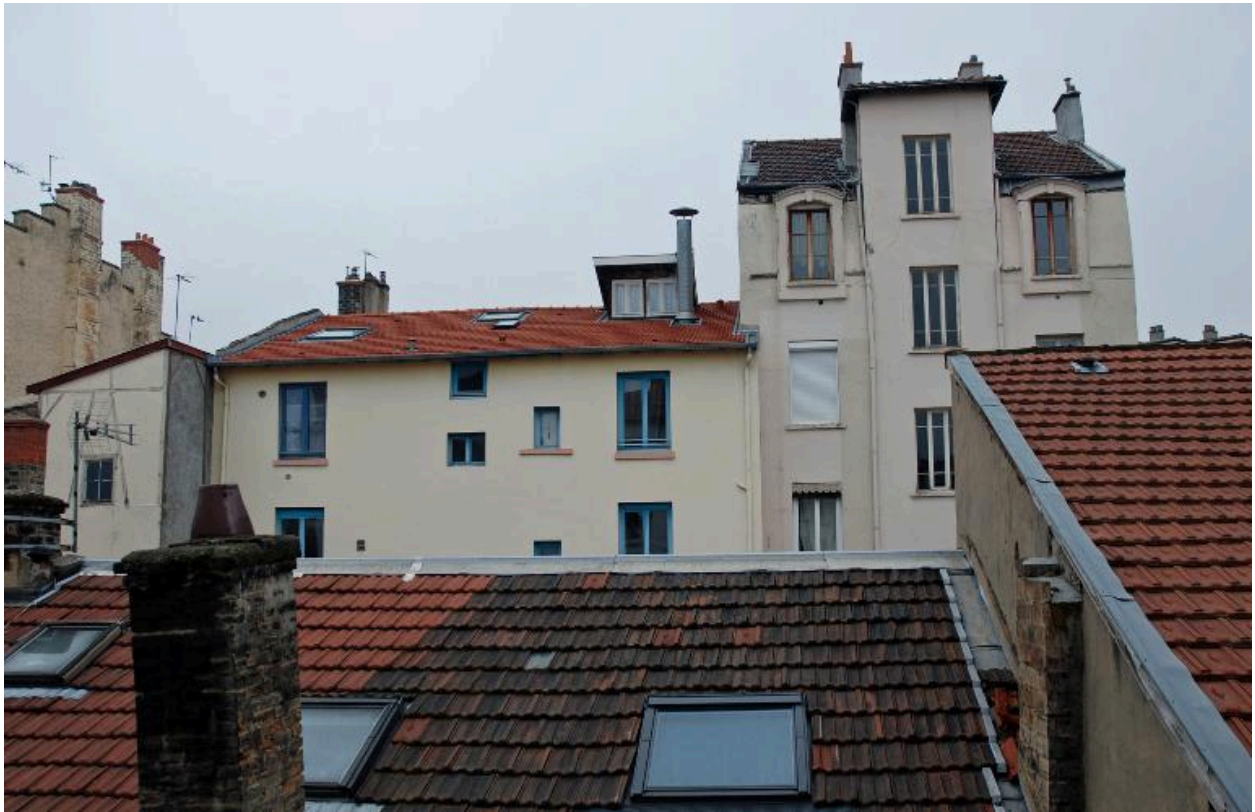
Vue générale de l'élévation sur cour (au centre)
