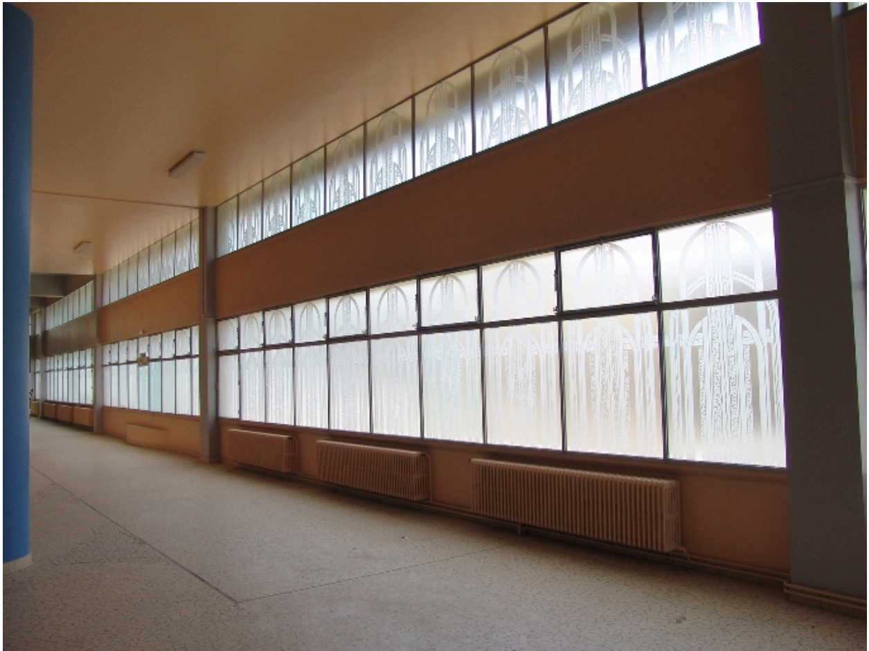
Galerie du 2e étage de soubassement
