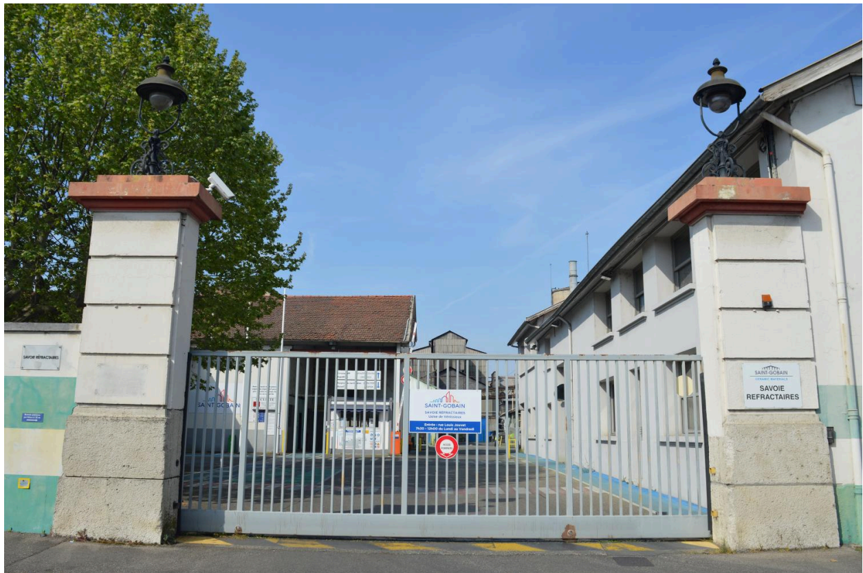
Saint-Gobain - Savoie Réfractaires - vue de l'entrée du site rue de l'Industrie
