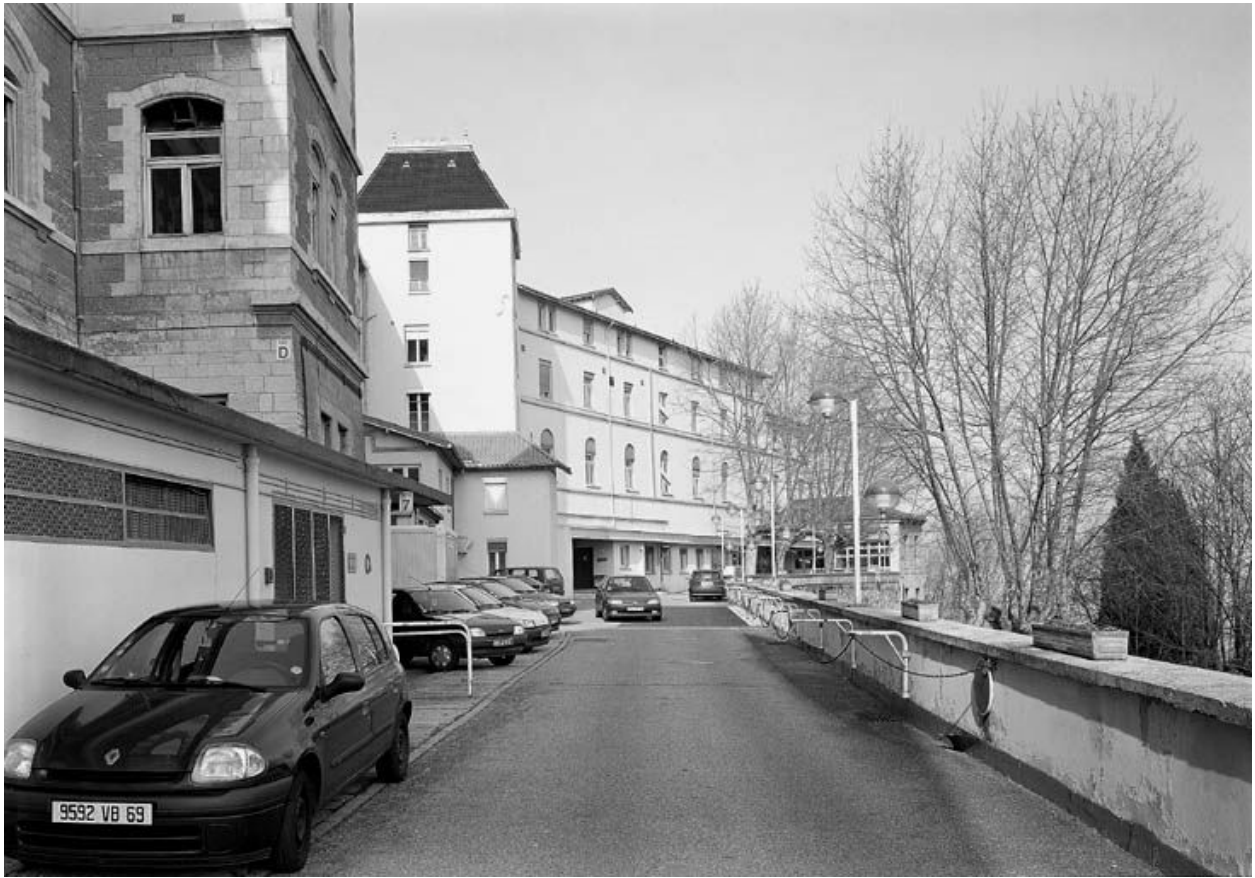
Bâtiment 12, façade principale à l'est
