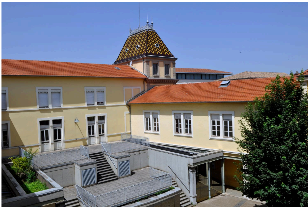
Cour 3 : vue d'ensemble depuis le sud-est et toits terrasses de la salle Agora
