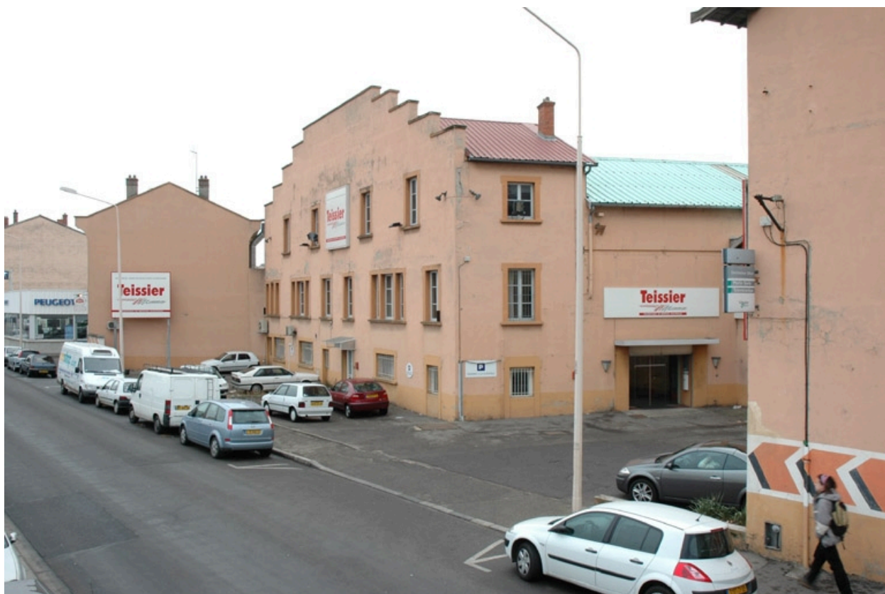
Vue générale nord-est
