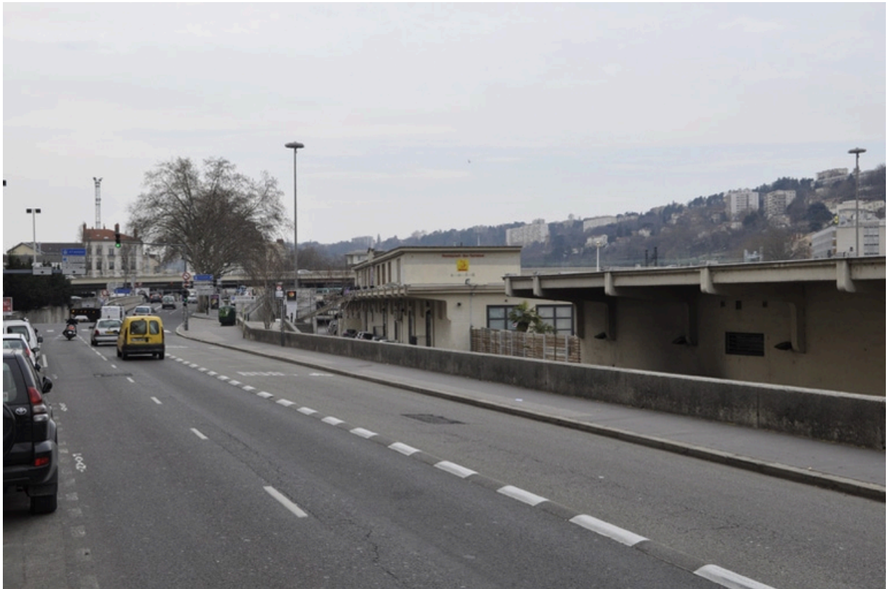
Vue nord-est du site du quai Maréchal Joffre
