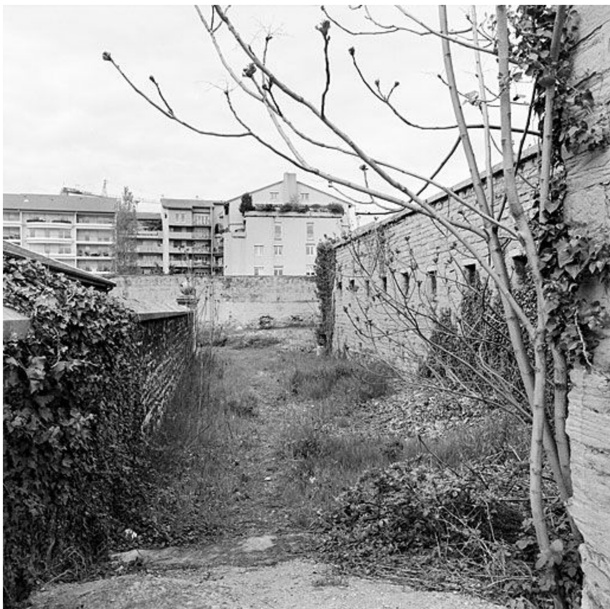
Vue intérieure du mur d'enceinte rue Victorien sardou
