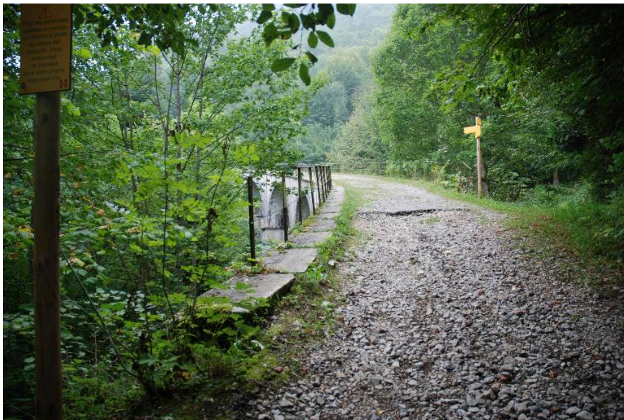
Viaduc des Fontanettes : tablier.
