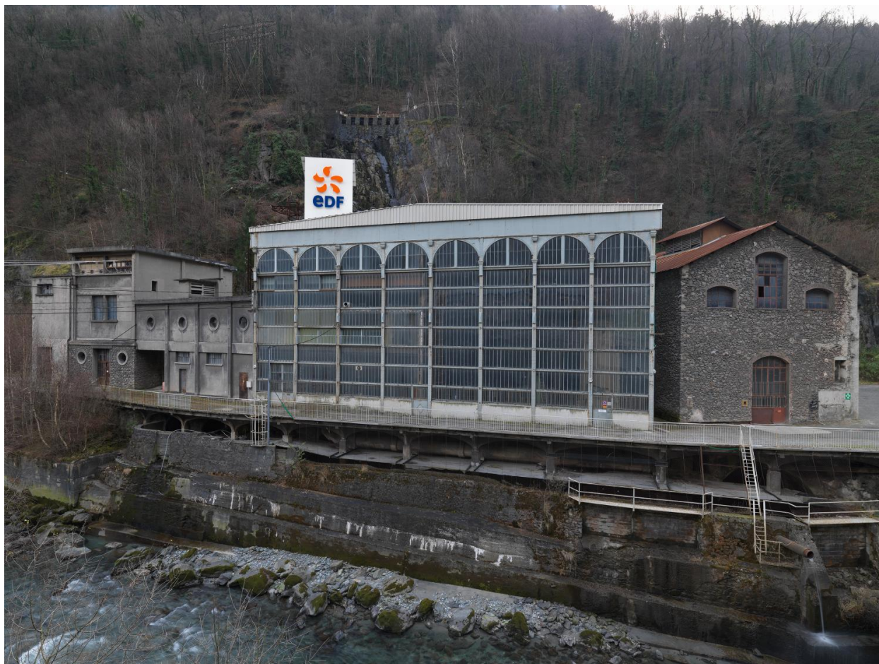
Façade principale de la centrale de Livet
