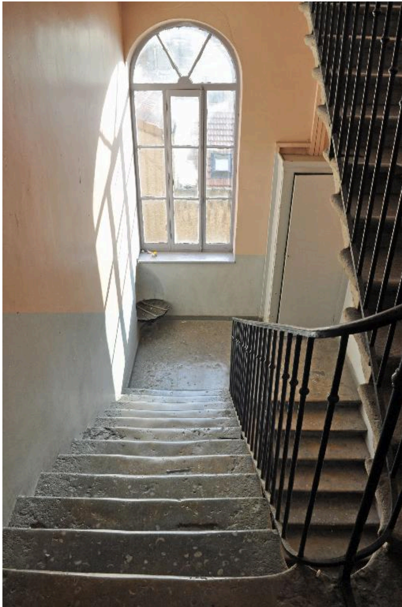
Vue intérieure : cage d'escalier, anciennement ouverte
