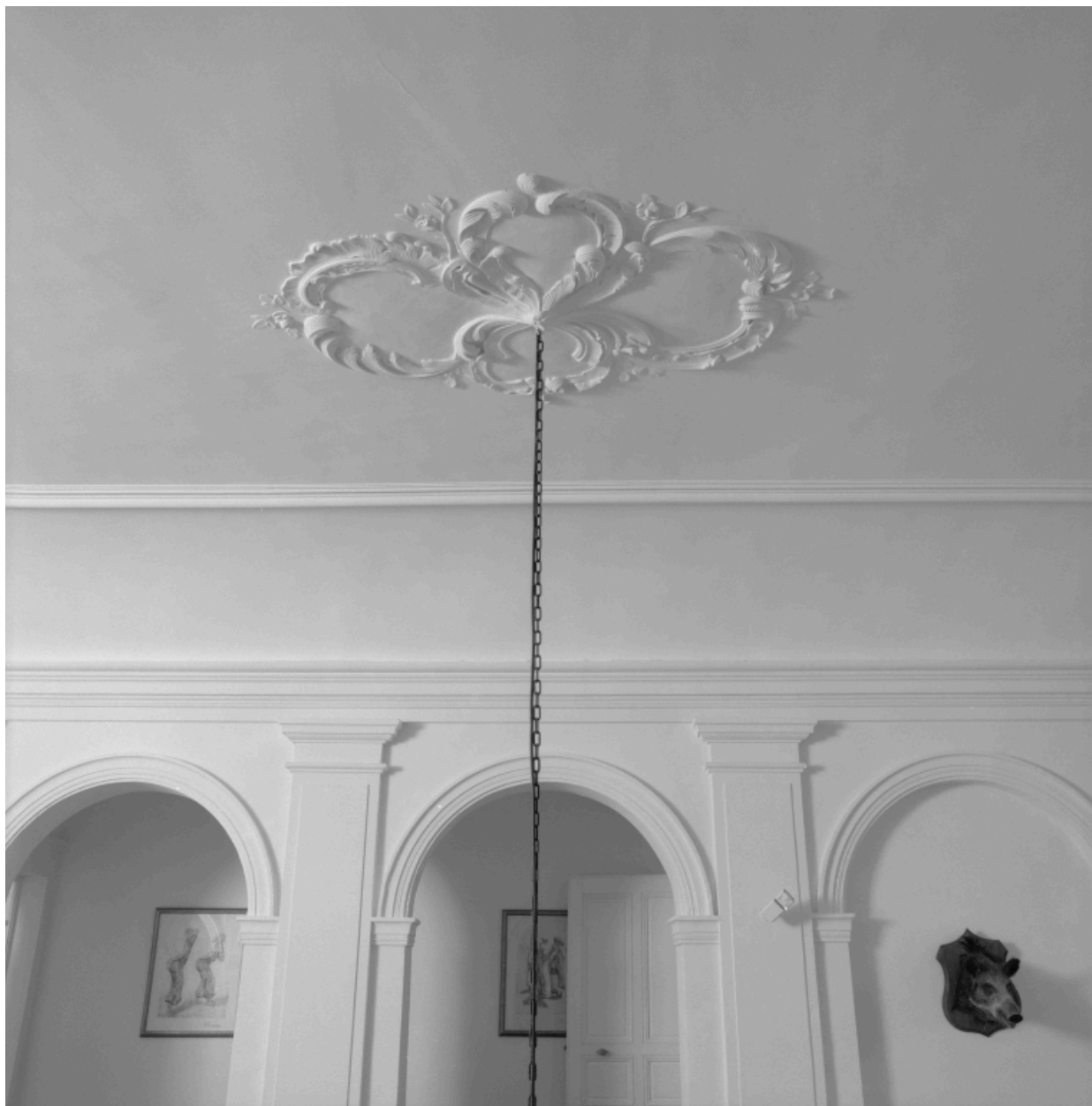
Premier étage, cage d'escalier : détail de la rosace en stuc du plafond.
