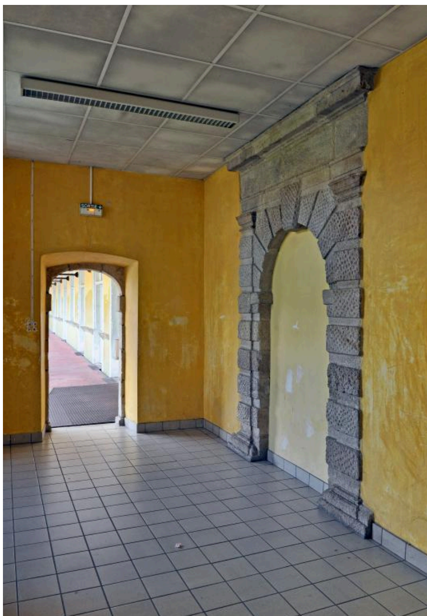
Bâtiment E, 1er étage : porte murée, ancien accès sud à l'église par le 1er étage de la galerie de la cour des classes
