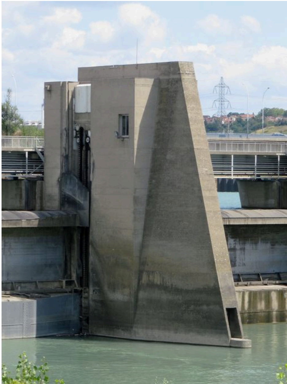
Vue d'un contrefort du barrage, face aval (depuis la rive droite)
