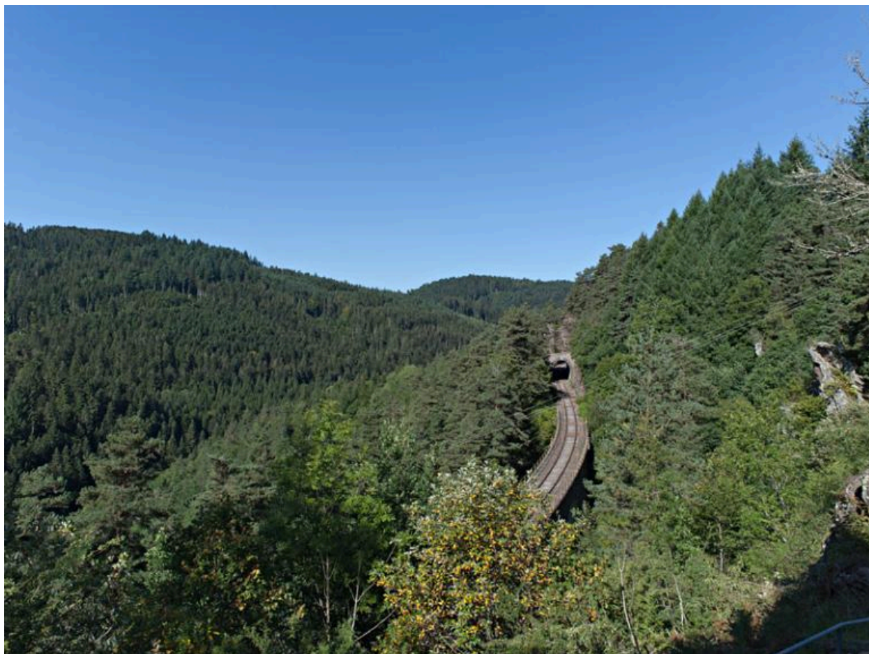
Site de la voie ferrée au niveau du viaduc du Merle.
