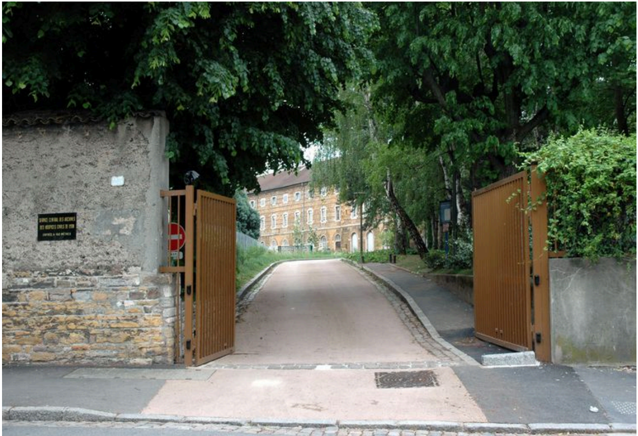
Vue du portail d'entrée, 23 rue Roger-Radisson
