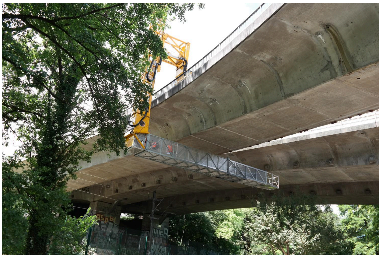
Viaduc de Cran, visite d'inspection
