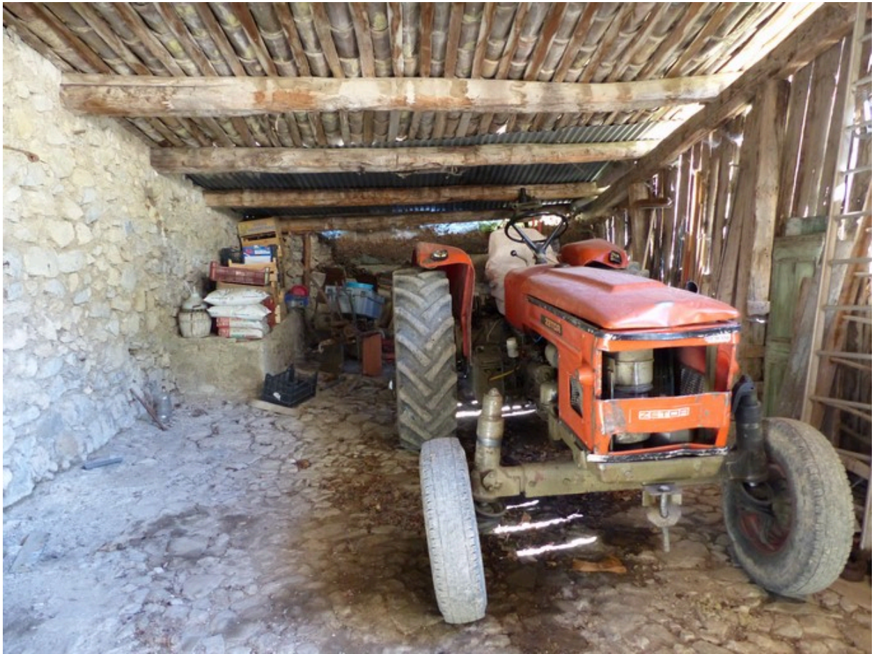
Hangar nord, vue de volume prise du sud.
