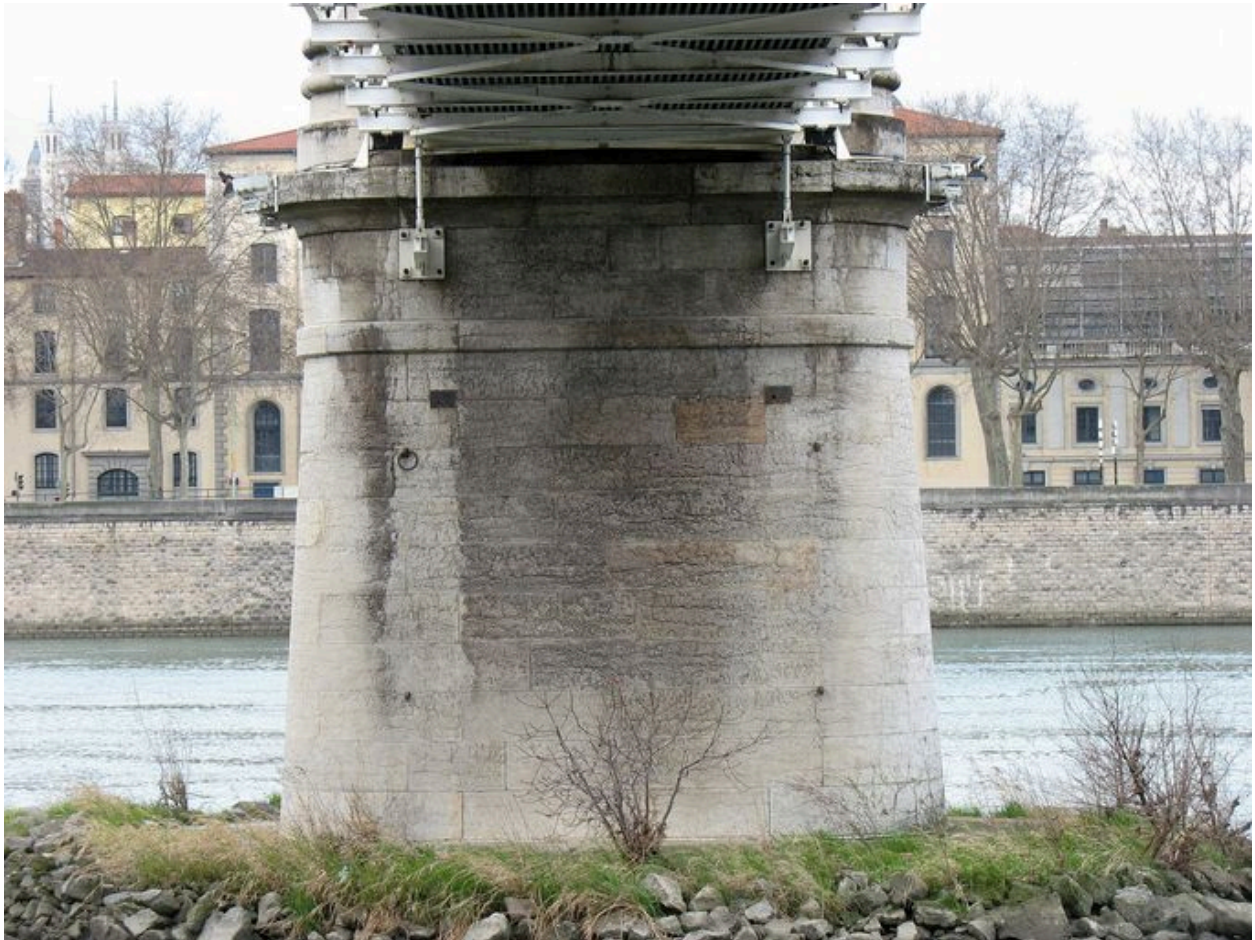
Pylône de gauche (est) : vue du socle inférieur
