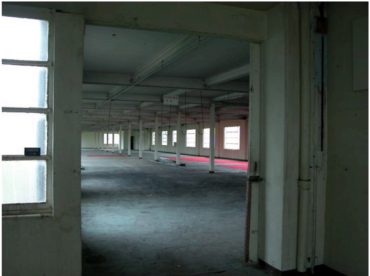
Aile nord de l'usine avec des piliers et poutres en acier.
