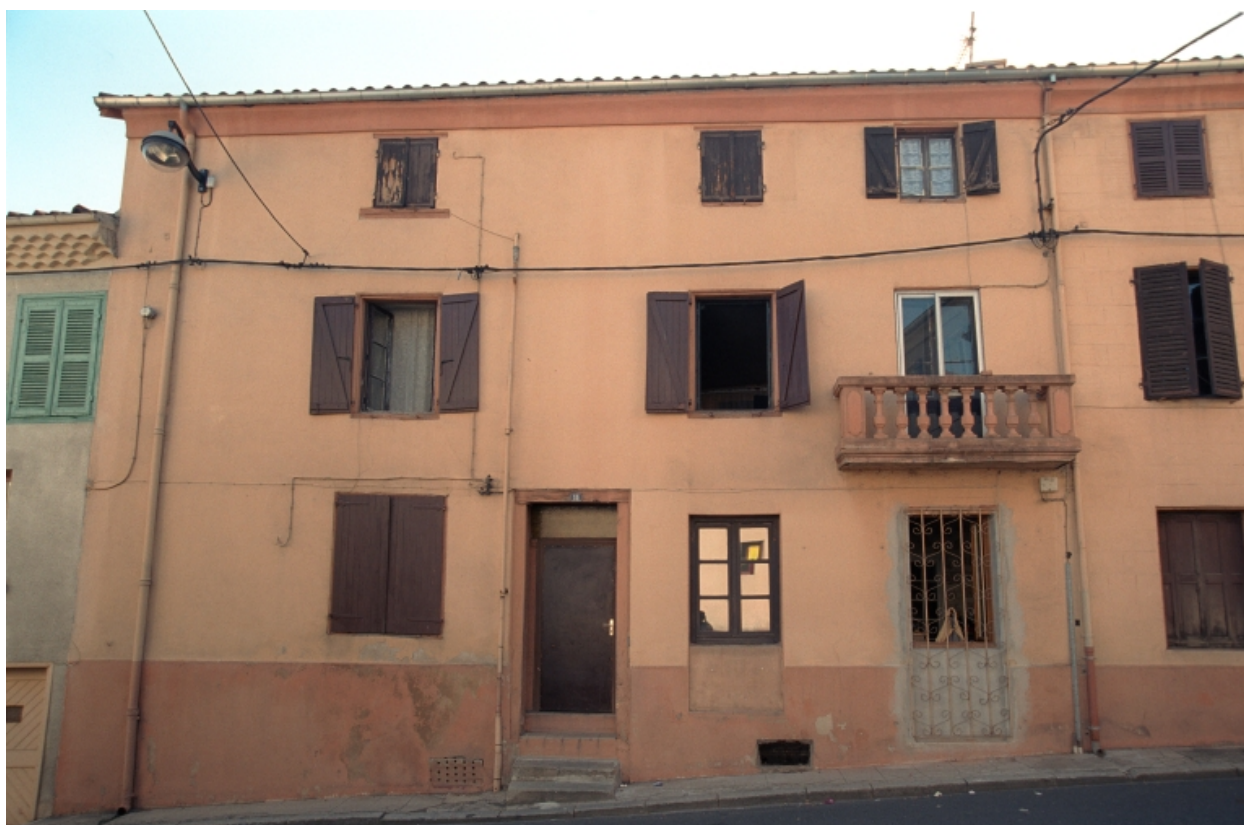
Boën, îlot 16, 8 Mai 1945 (rue du) 11. Vue générale de la façade sur rue.
