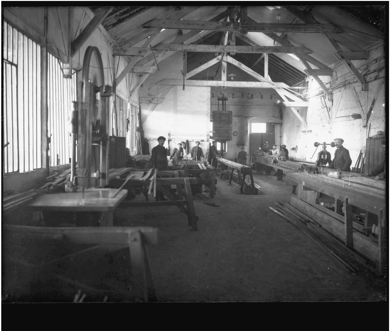
Vue intérieure de l'usine, vers 1920, AD 69 : série 158 J. plaque de verre, usine Tréfimétaux AD Rhône. 158 J
