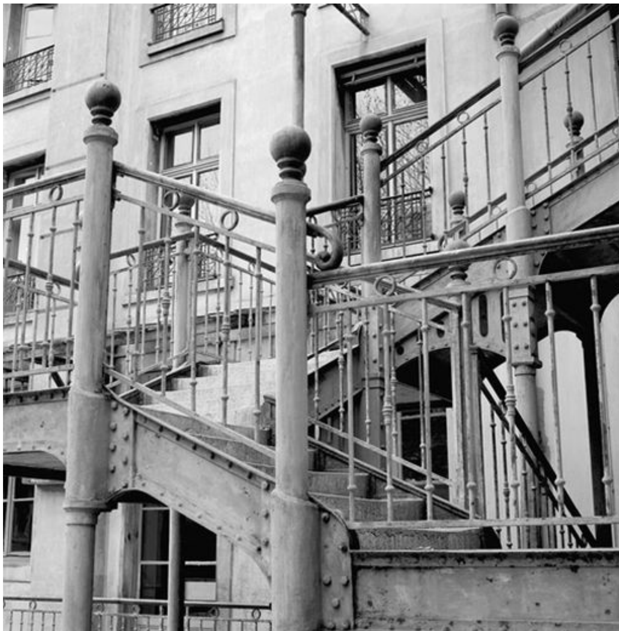
Ecole Ozanam, escalier hors-oeuvre de la cour : partie médiane
