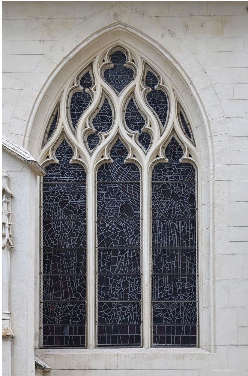
Elévation ouest, baie 5
