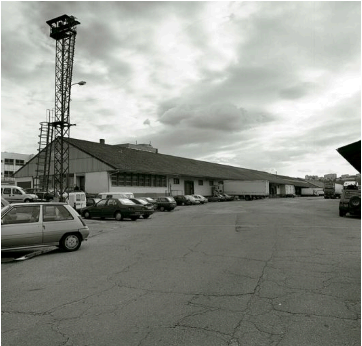
Entrepôt commercial de la société Pascual
